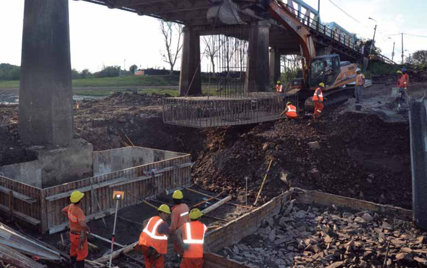
Construcción del puente de Paso del Bote, en Tacuarembó: una obra conjunta entre OPP y la Intendencia departamental
