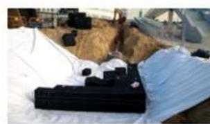
Construcción de un depósito de infiltración con cajas reticulares en la Nueva Sede BBVA en Madrid. Fuente: Ayto. de Madrid.
