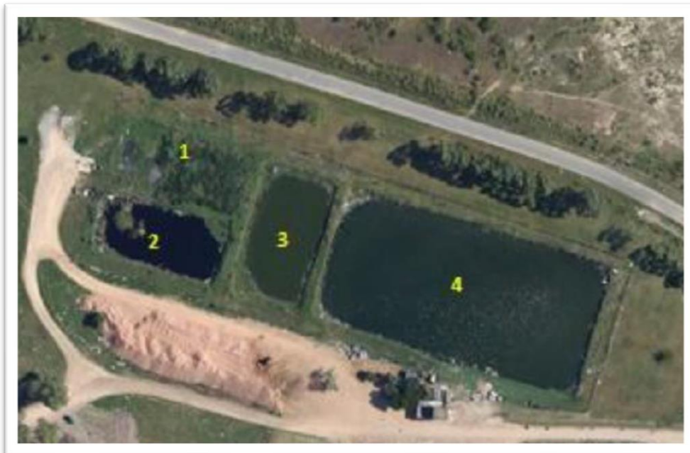
Sistema actual de lagunas a intervenir
