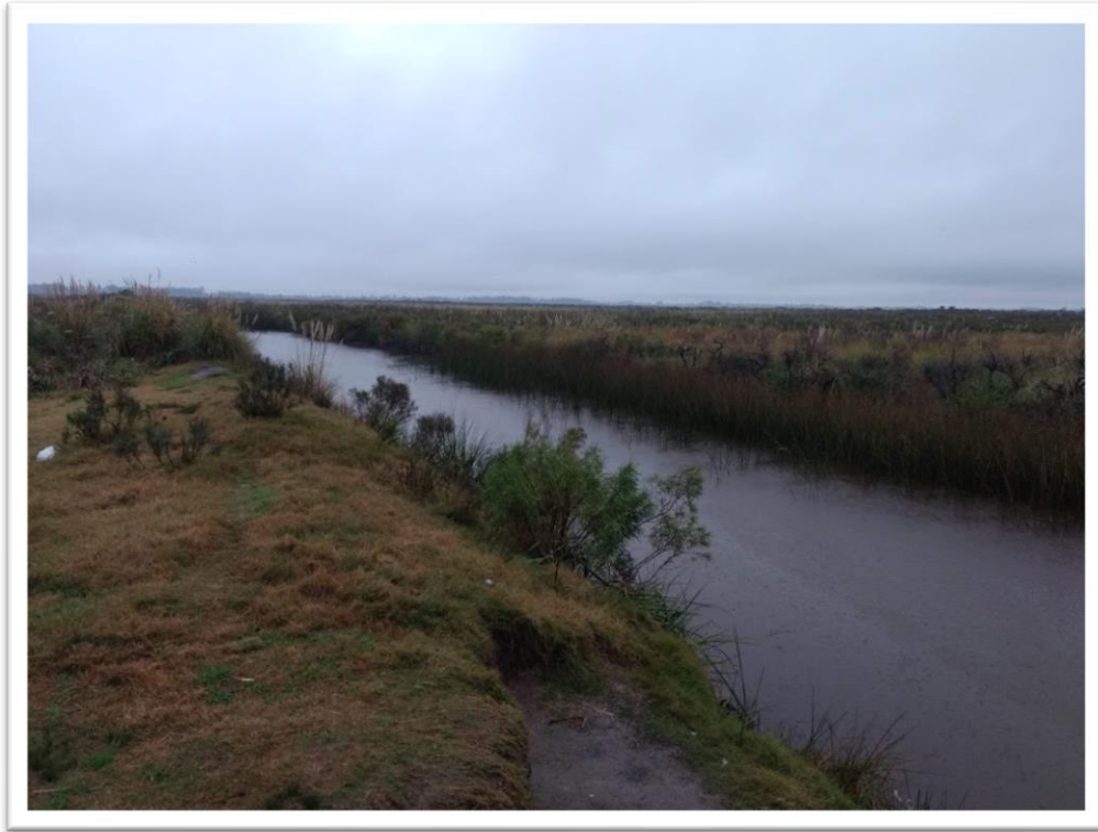
Vista del canal de desagüe, a la altura de la desembocadura en el río Santa Lucía (Fuente: imagen propia)
