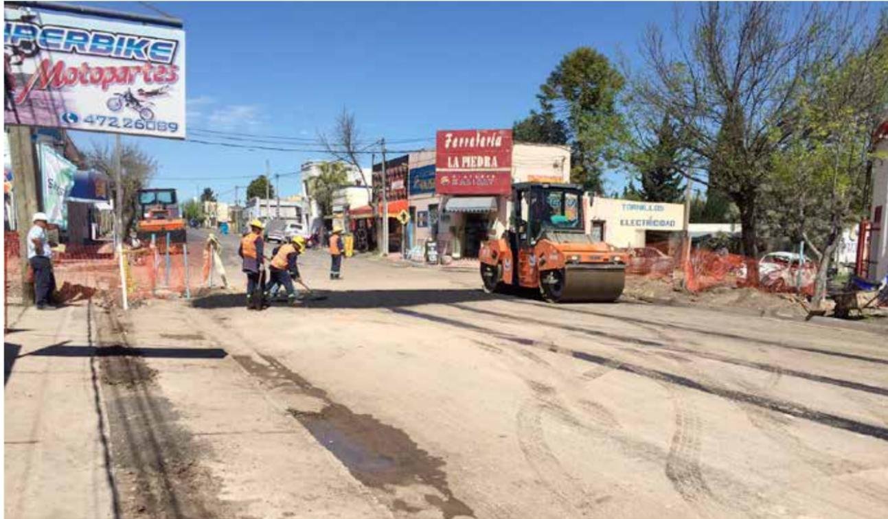
Preparación de superficie para la colocación de carpeta asfáltica.
