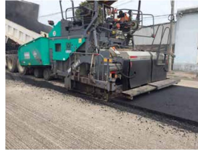
Terminadora de concreto asfáltico trabajando.
