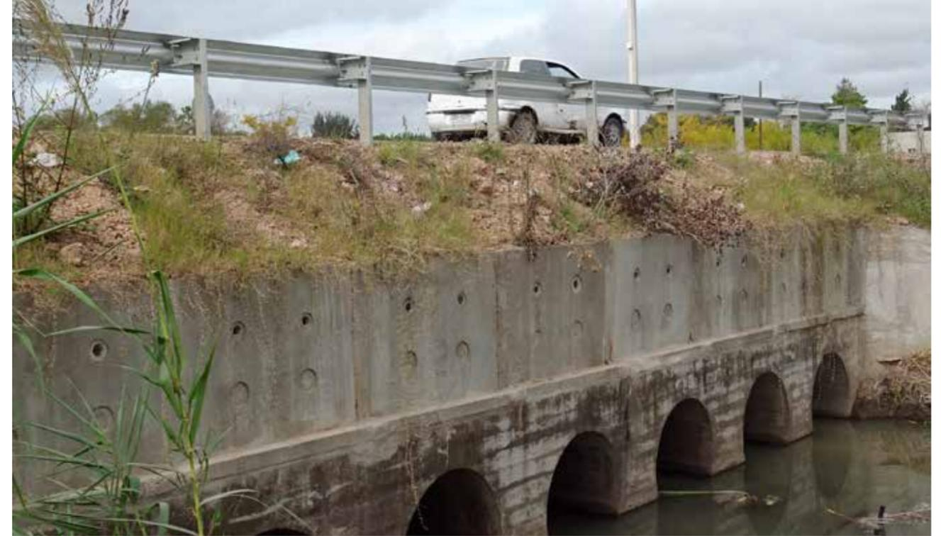
Muro de contención en alcantarilla necesario para el ensanche de plataforma.
