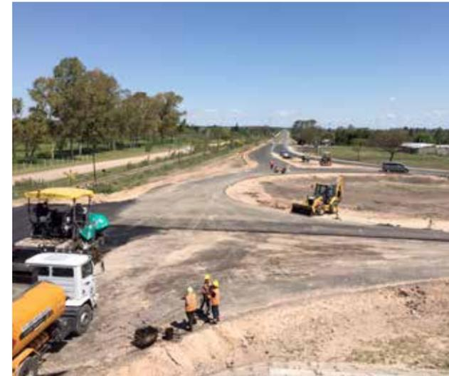
Colocación de carpeta asfáltica en intercambiador.
