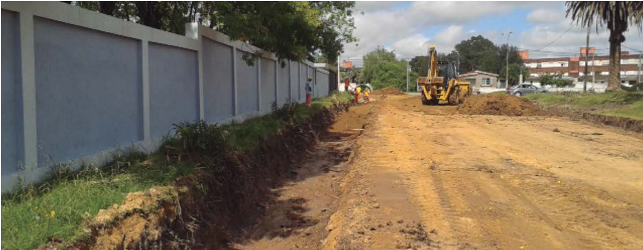
Construcción de cordón cuneta.
