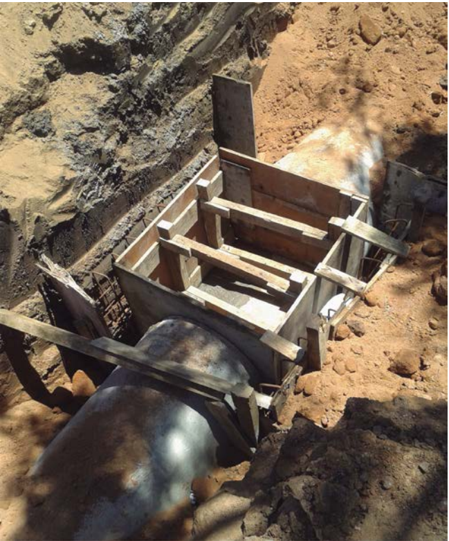
Construcción de puntos de inspección.
