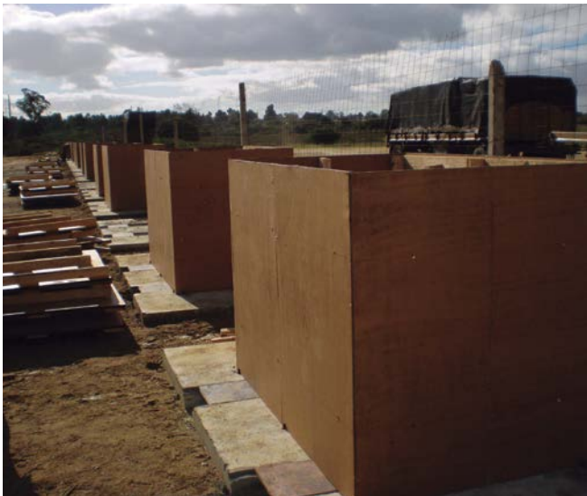
Moldes preparados para el llenado con hormigón.
