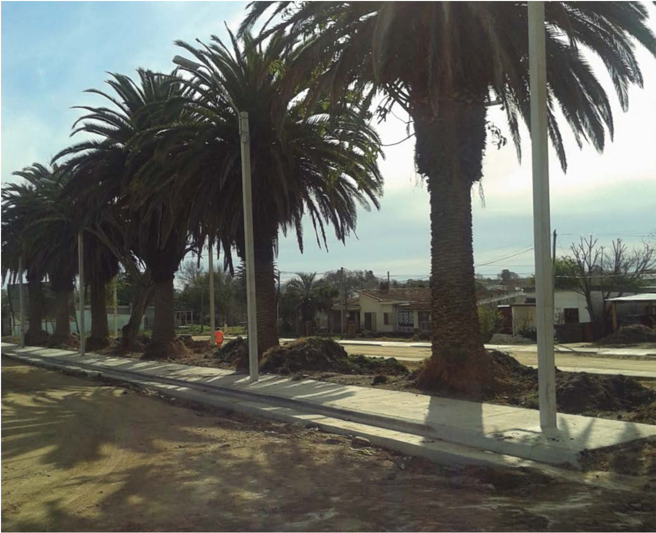
Conformación de cordón cuneta en zona de plazoleta.
