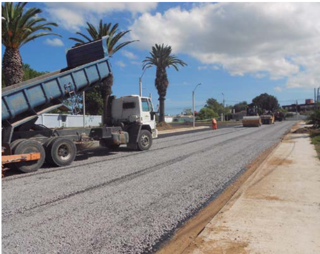
Tendido de tratamiento asfáltico en las calles.
