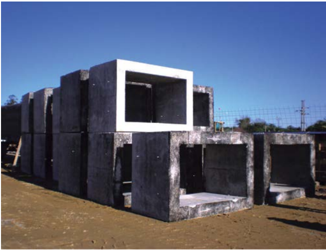
Acopio de piezas prefabricadas en el obrador.
