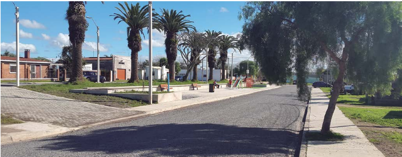
Proceso de obra Bulevar Uriarte, vista desde el Estadio Mario Sobrero.
