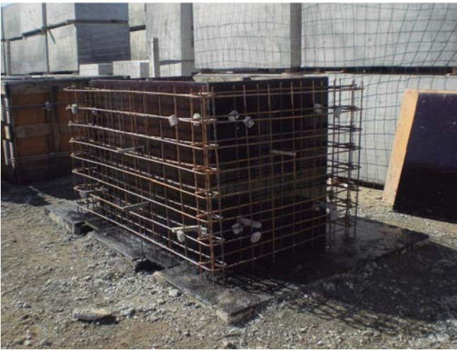
Armadura de piezas prefabricadas.
