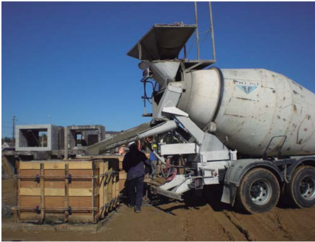
Llenado de moldes en el obrador.
