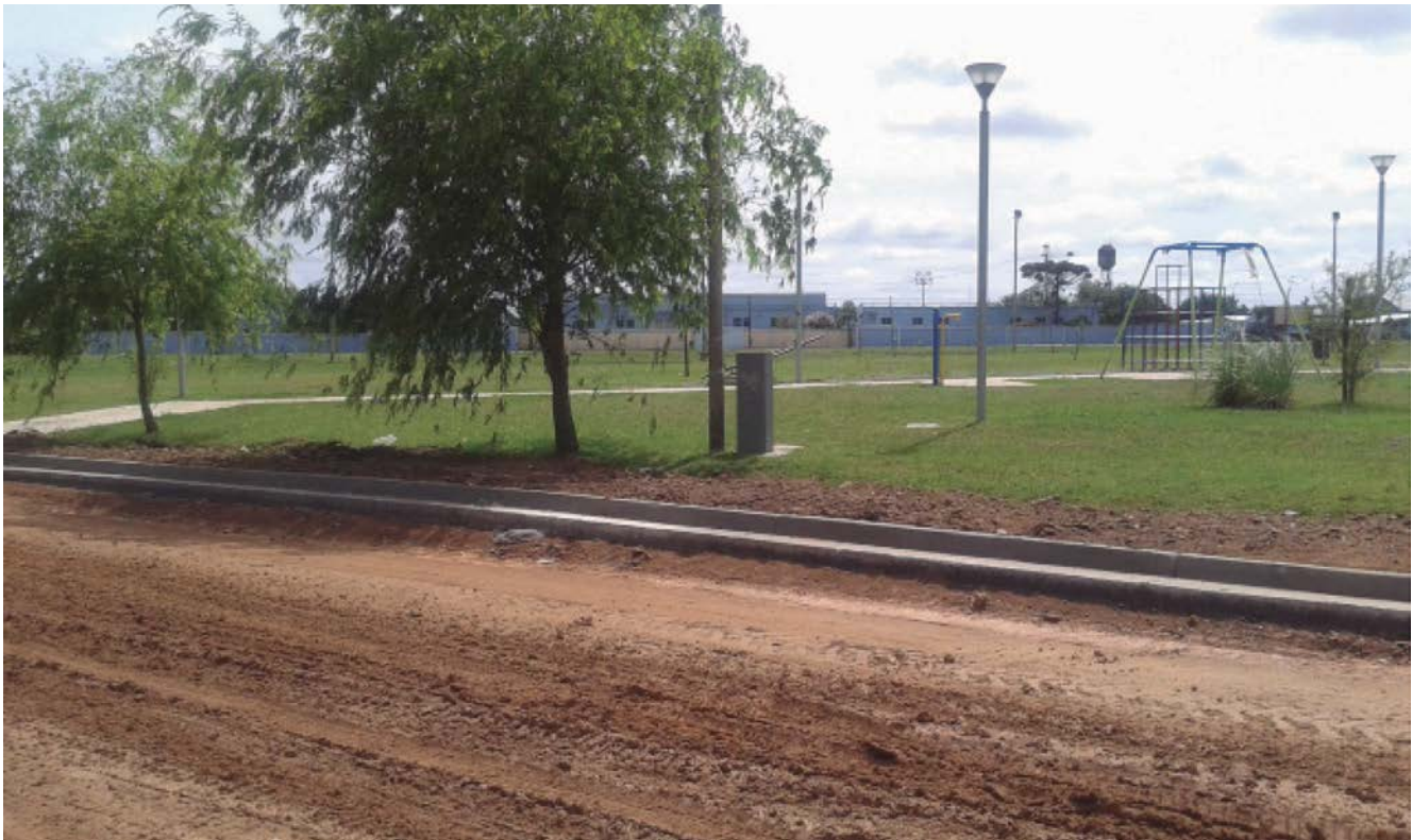
Construcción de cordón cuneta.
