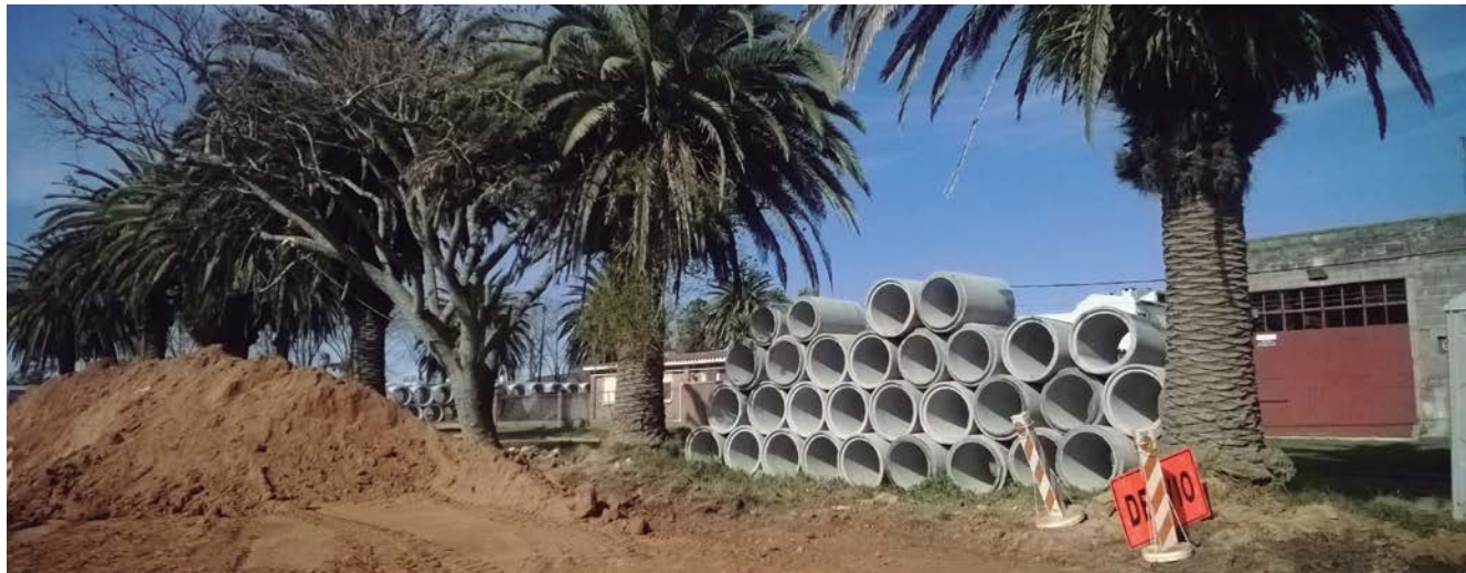
Colocación de caños de hormigón para conformación de colectores pluviales.
