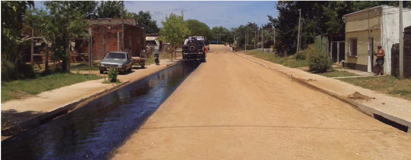
Asfaltado de calles.
