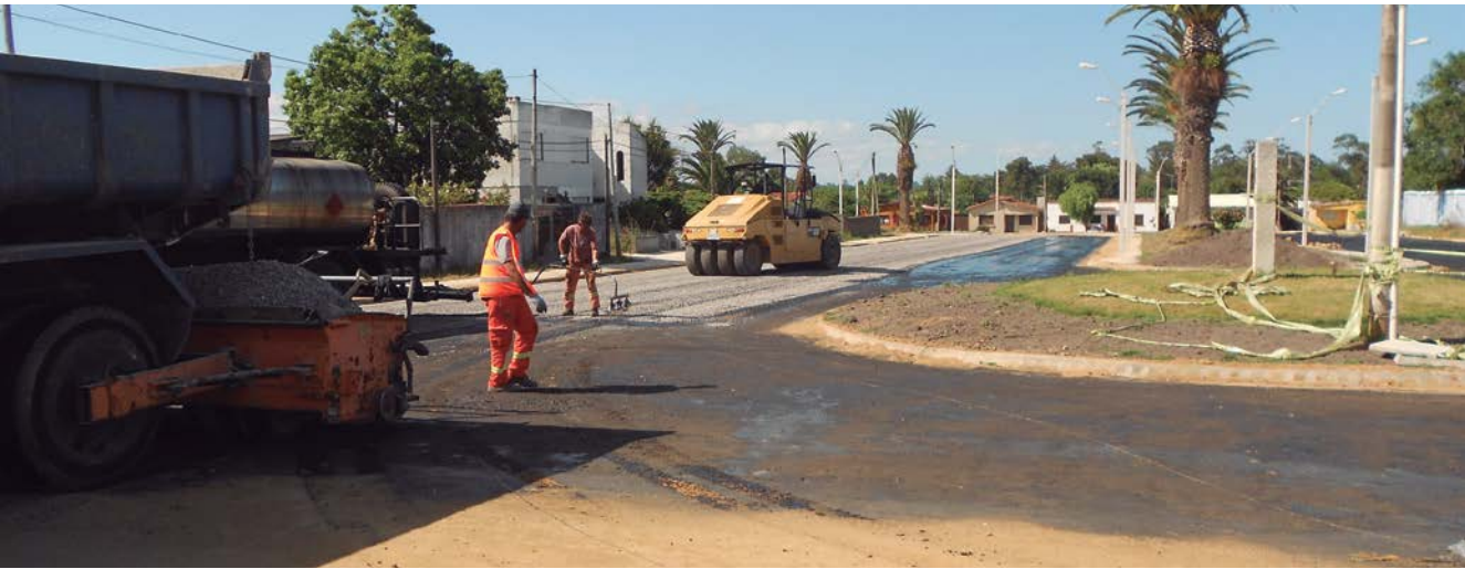
Tendido de tratamiento asfáltico en las calles.
