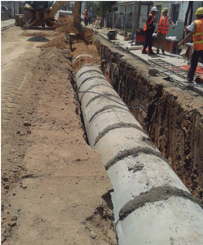
Colocación de caños de hormigón para conformación de colector pluvial.
