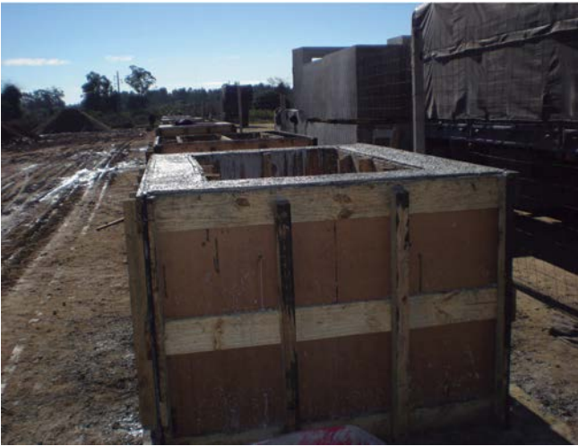
Pieza prefabricada llenada.
