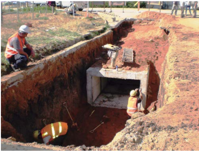
Montaje de colector rectangular.
