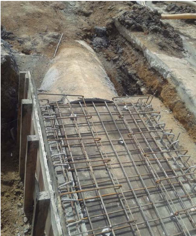
Tramo de colector construido in situ para salvar instalaciones existentes.
