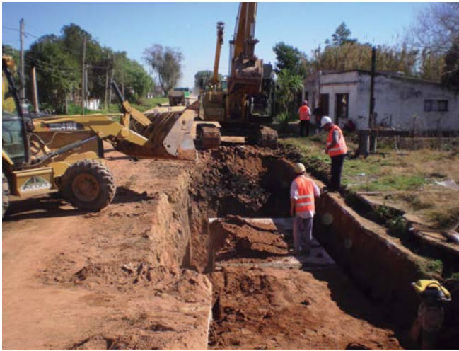
Montaje del colector rectangular de hormigón armado con piezas prefabricadas.
