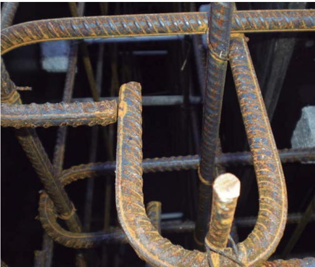
Detalle de armaduras.
