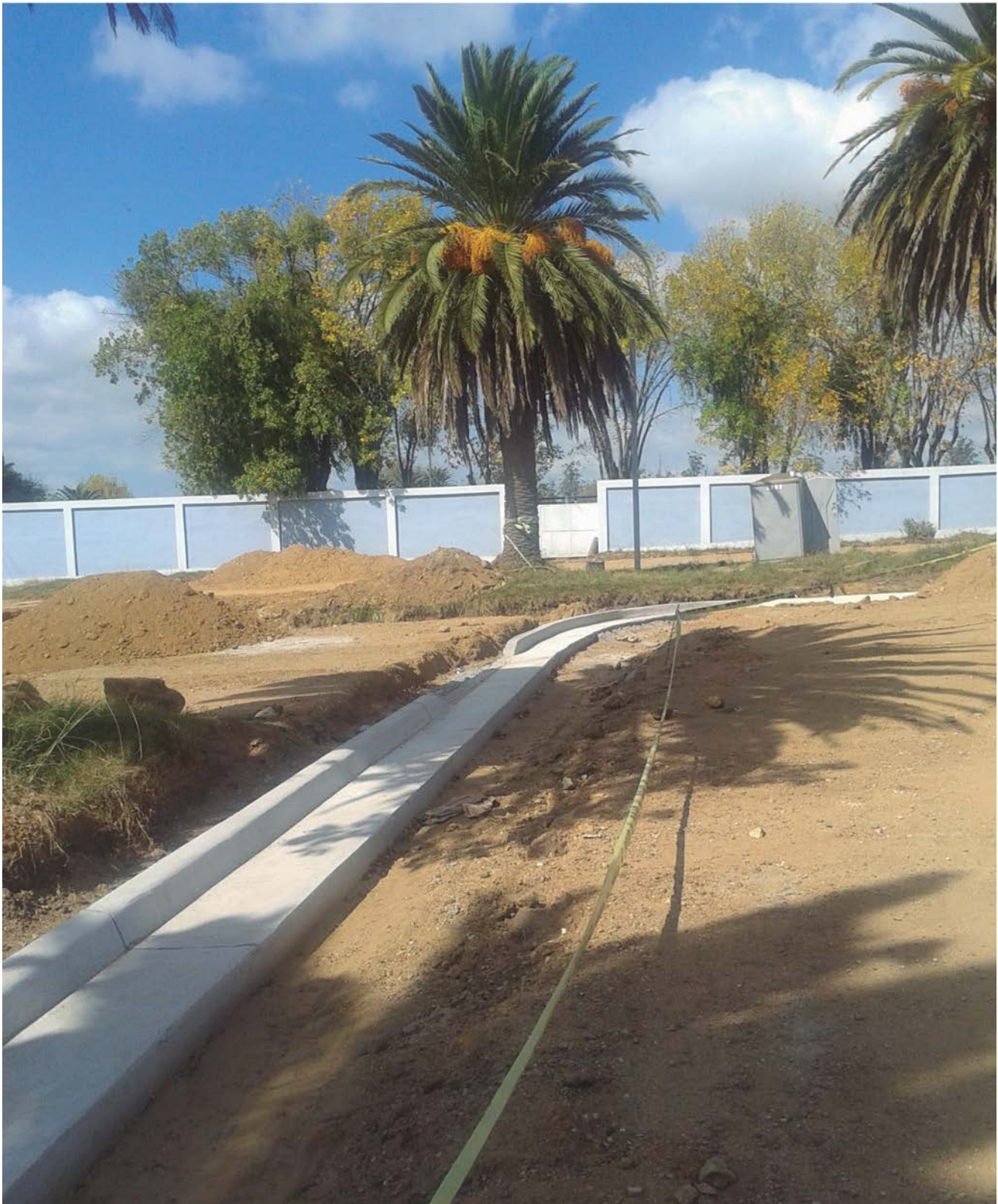
Conformación de espacio para plazoleta mediante construcción de cordón cuneta.
