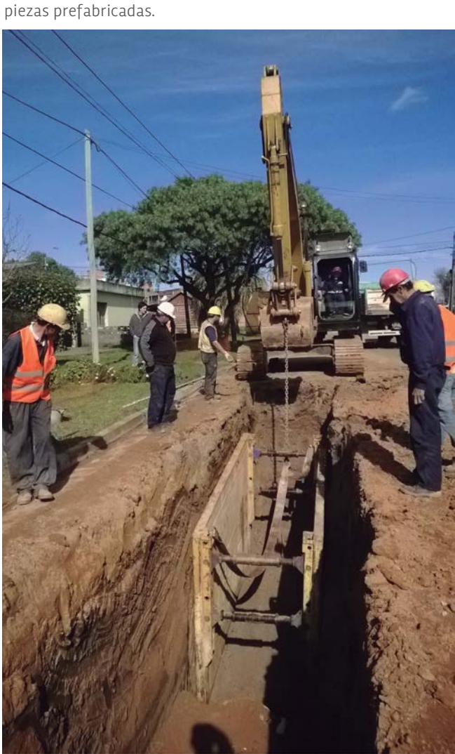
Entibado de zanjas para colocación de tuberías de hormigón.
