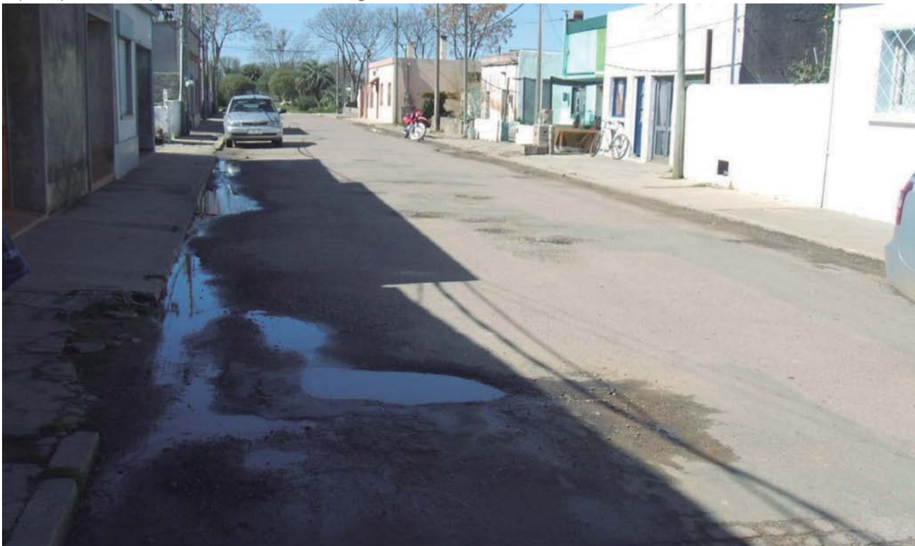
Pavimentos en mal estado y falta de drenajes pluviales.
