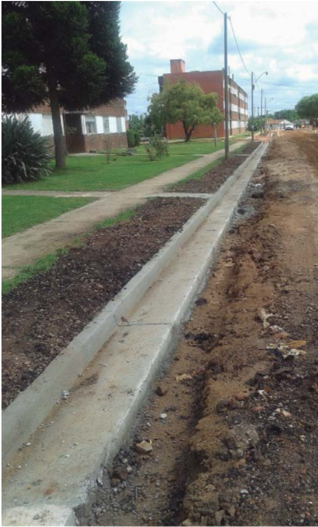
Construcción de cordón cuneta.
