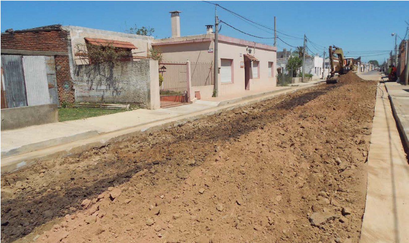
Conformación de bases de pavimentos.
