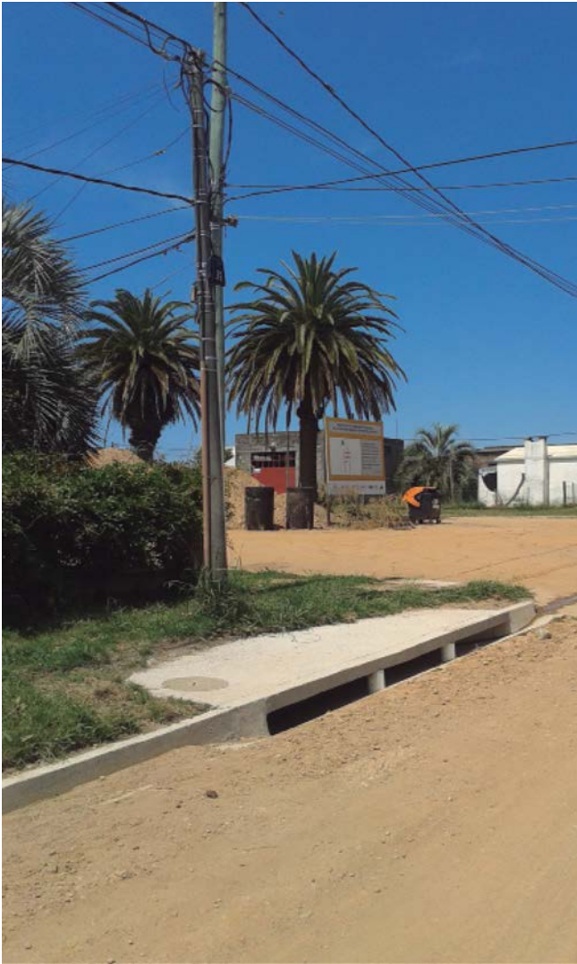
Construcción de bocas de tormenta.
