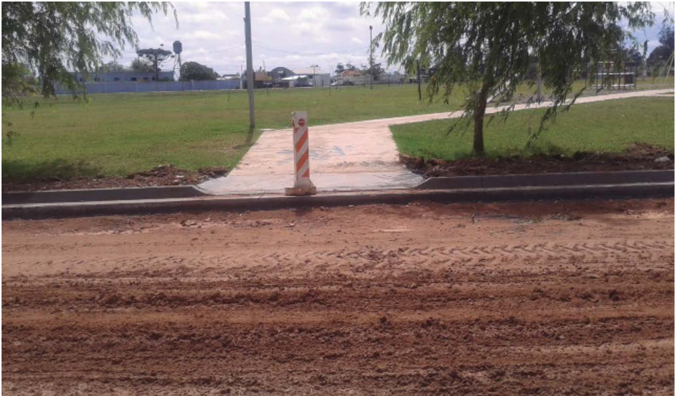
Construcción de cordón cuneta.
