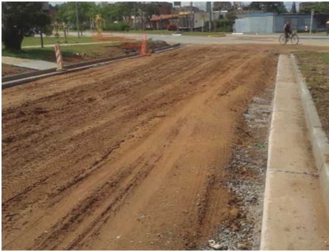
Construcción de cordón cuneta.
