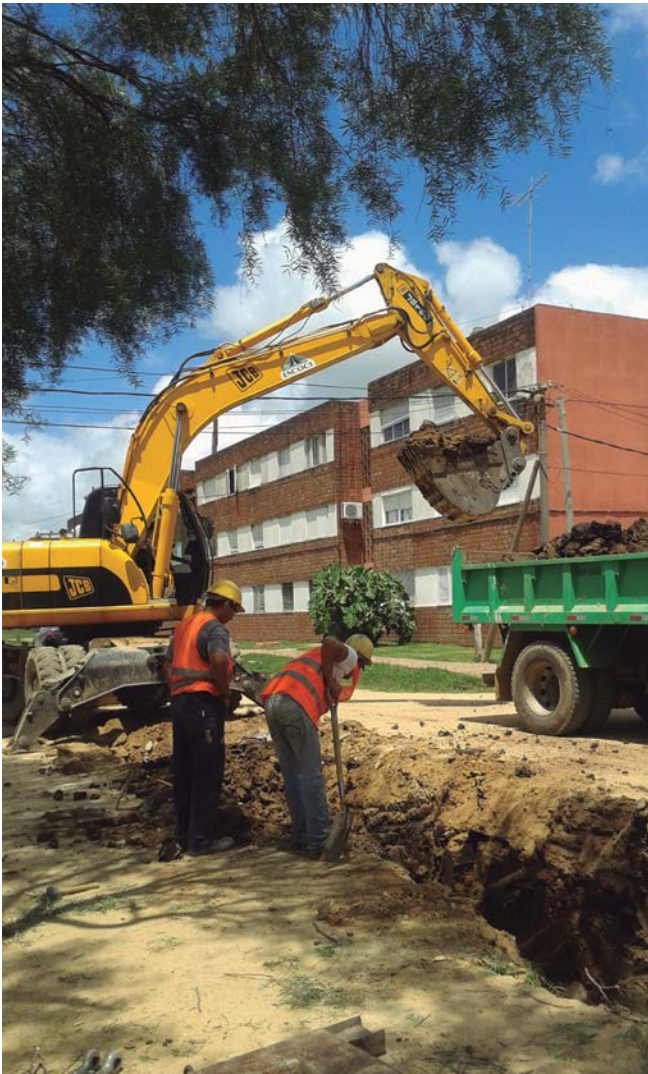
Trabajos en la calle Víctor Barrios.
