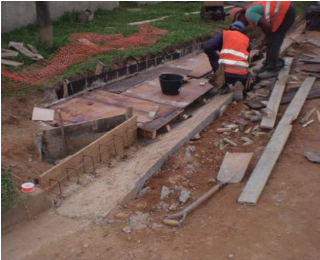
Construcción de bocas de tormenta.
