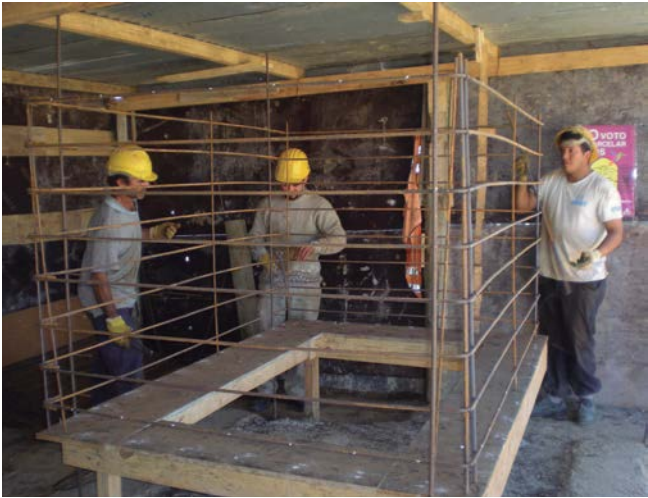
Fabricación y montaje de las piezas prefabricadas de hormigón armado.
