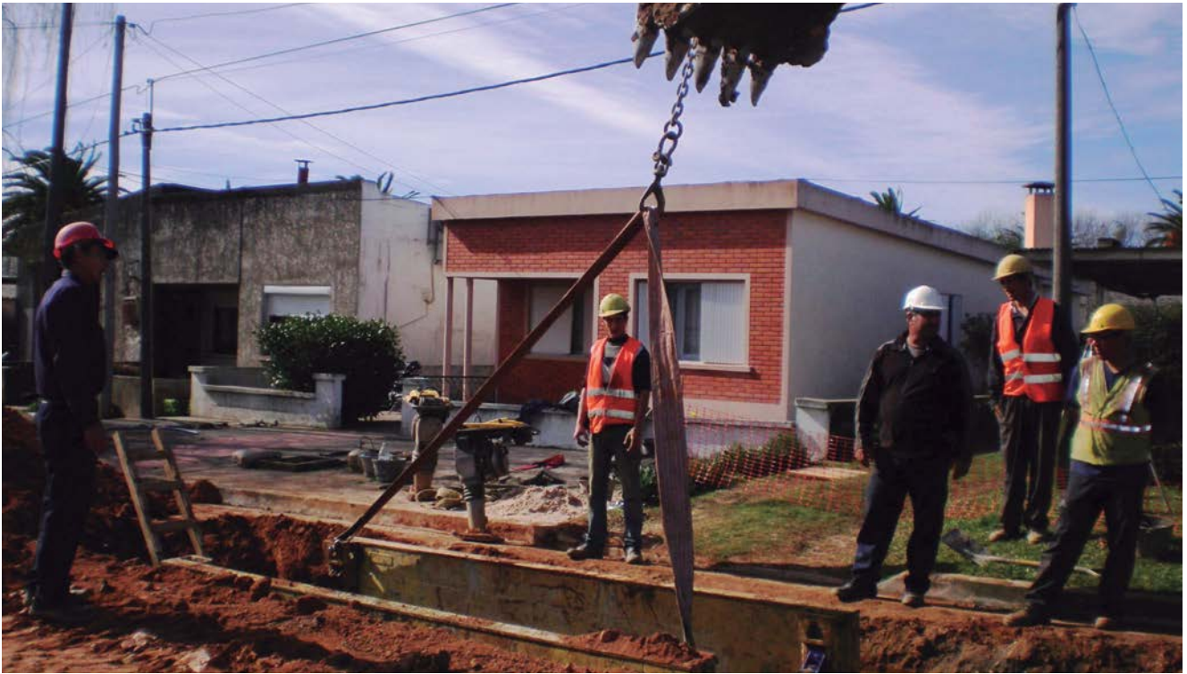
Colocación de piezas de entibado para protección de zanjas.
