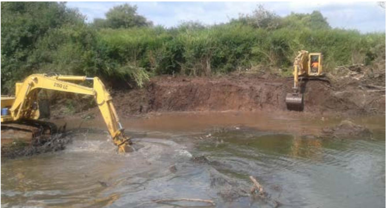
*Extracción de sedimentos y perfilado de talud*
