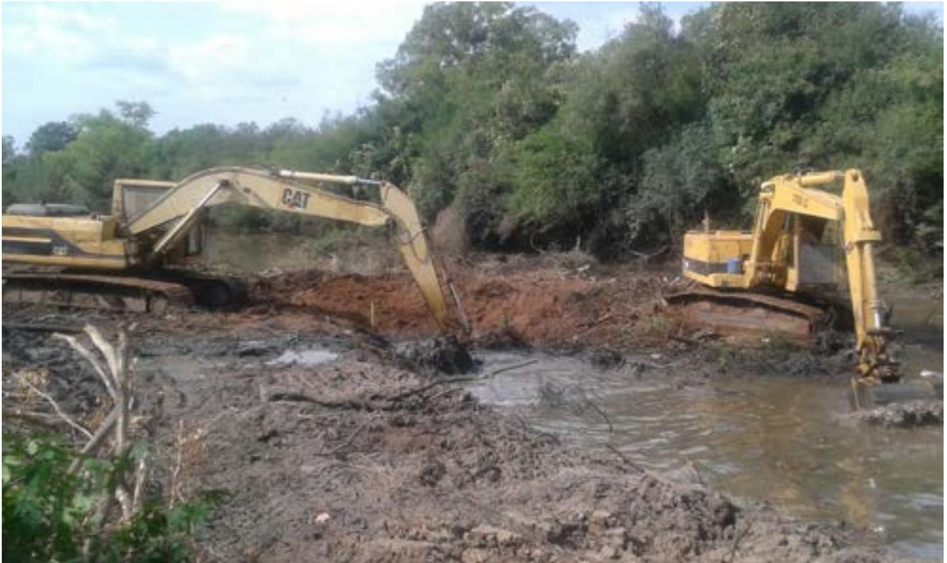
*Excavación para extraer sedimentos del cauce sobre última zona de intervención aguas abajo*
